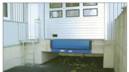
KRAUS Überladerampe mit Klapplippe eingebaut in Verbindung mit einem Sektionaltor
